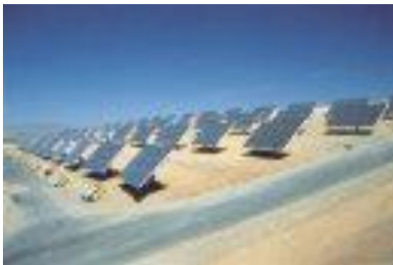
スペイン 1.2MW
